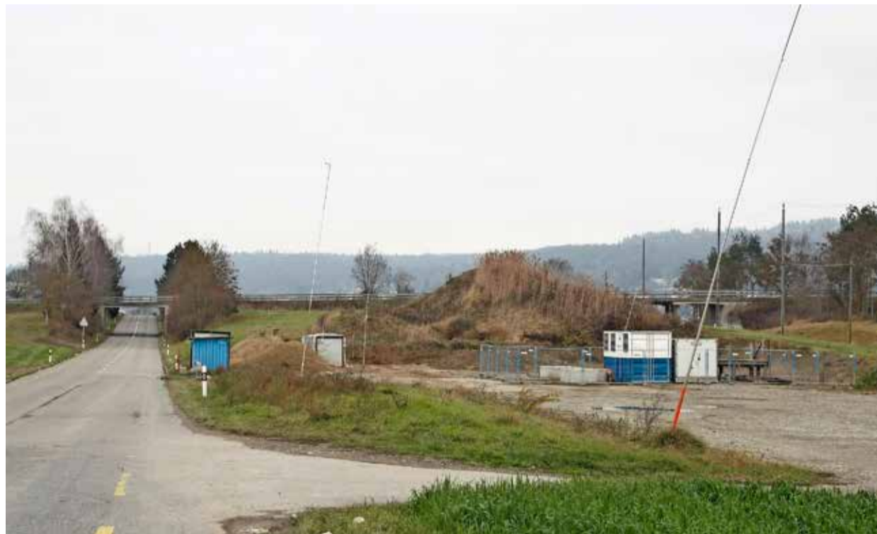
Auf diesem Grundstück in der Landwirtschaftszone ist der Bau der Biogasanlage geplant.
